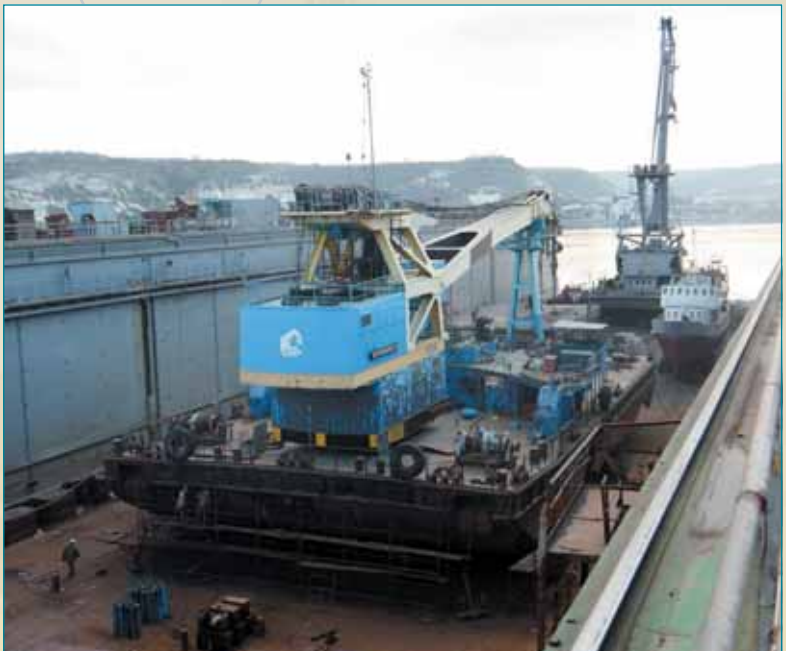
На половине стпель-палубы 30-го дока легко поместились два плавкрана и понтон ЗАО «Морстрой»
