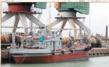
...и восстановительный ремонт сборщика отходов «Цискара»
