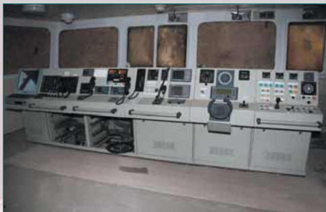
Монтаж пульты судовождения производства ОАО «Николаевская ЭРА»
