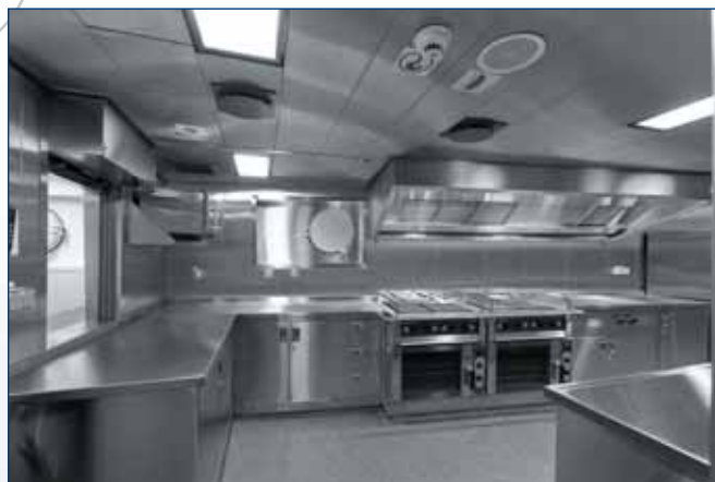
Весь камбуз выполнен из нержавеющей стали
