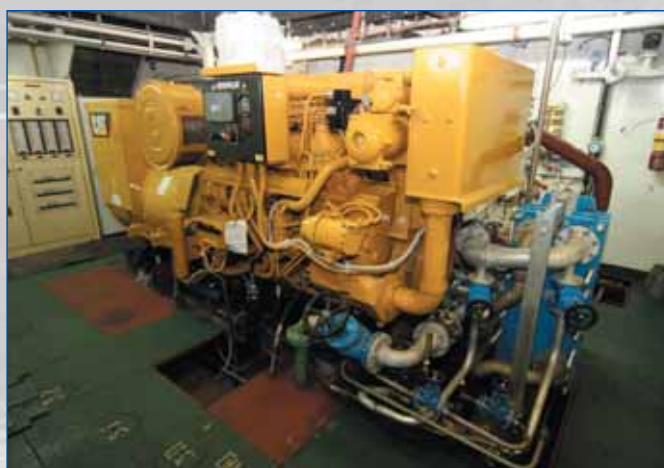
Дизель-генератор Caterpillar на 60 Гц
