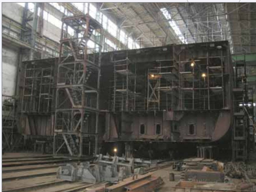
Блок вставки для удлинения судна-донора (ОАО «Херсонский судостроительный завод»)
