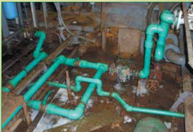
Установка новых систем в трюме судна
