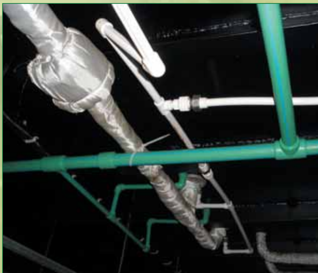
Монтаж пластмассовых трубопроводов завершен
