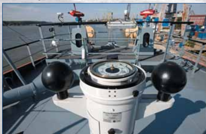
На верхнем мостике установлены два противопожарных монитора
