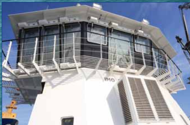
Ходовая рубка кругового обзора
