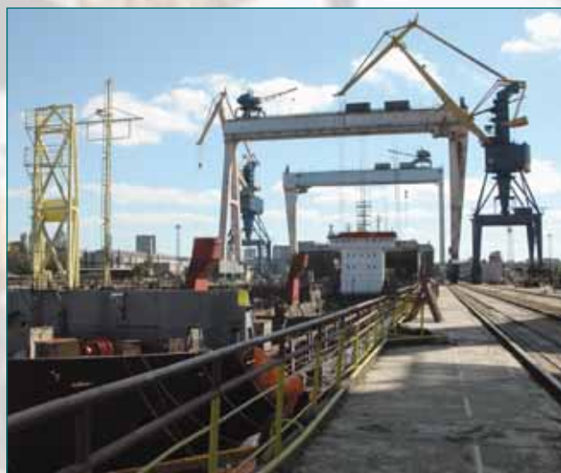
Сухой док «Океана»: судоремонт
