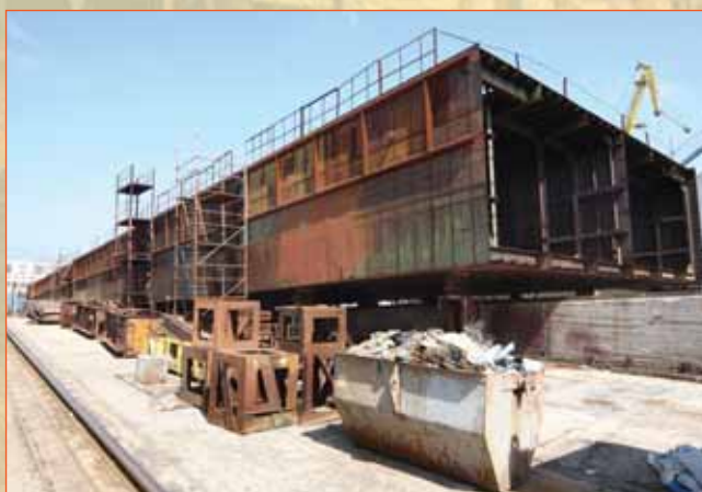
На стапеле «Севморзавода» понтон плавкрана г/п 1200 тонн
