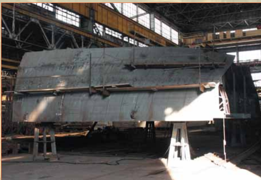
Сборка контейнеровоза на ГАХК «ЧСЗ»
