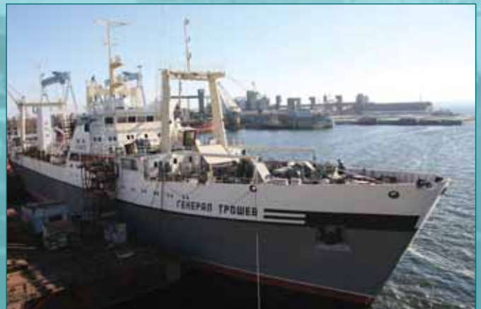
В достройке — траулер-рыбзавод, много лет простоявший у заводского причала
