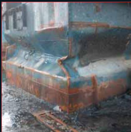
Деформация башни дока
