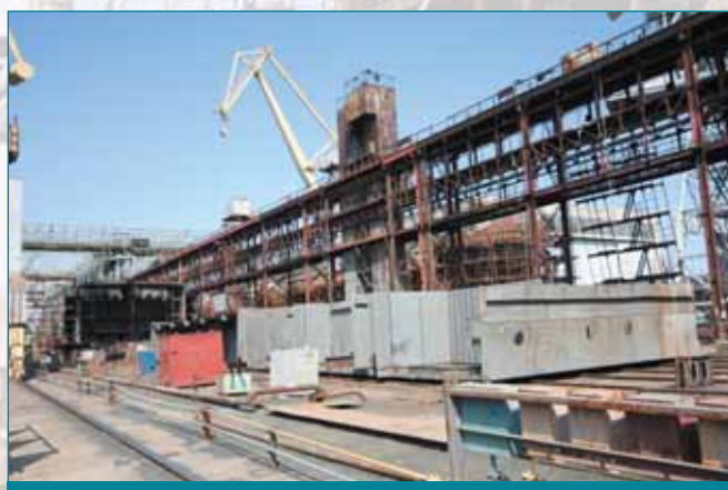
Конструкции судна перед монтажом
