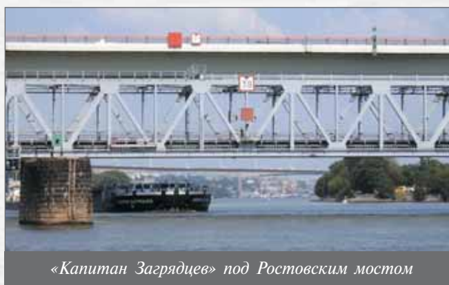
Проход под мостом — вид с судна
