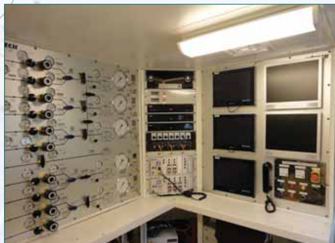
Интегрированный пульт управления, справа — консоль связи с водолазами
