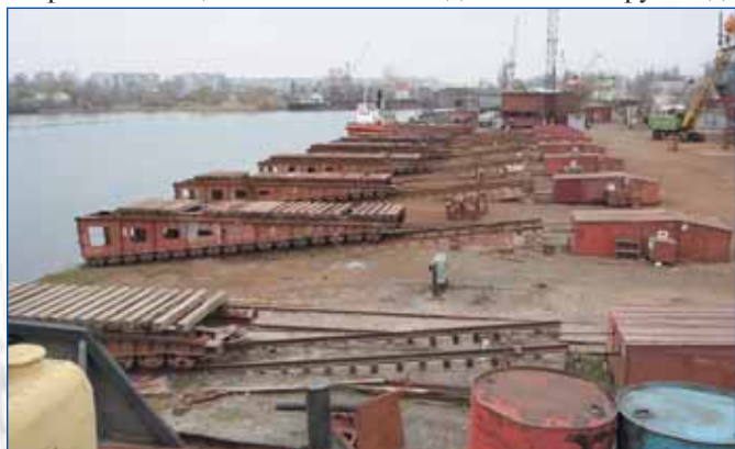
Слип ХССРЗ ожидает реконструкция
