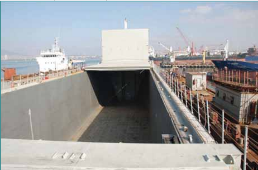
Люковые закрытия и трюм пр.DCV36
