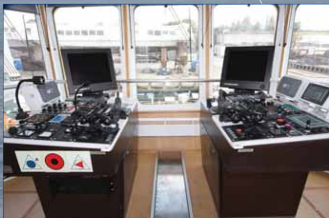
Главный пульт управления буксира «Темрюк»
