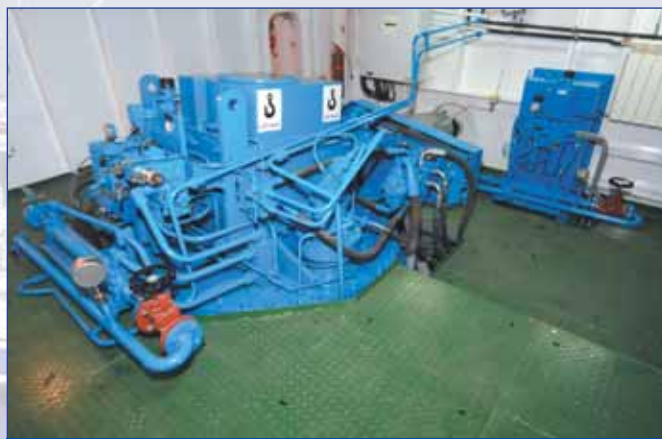
Помещение ВРК поражает простором
