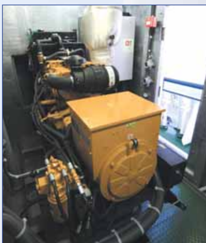
Аварийный ДГ расположен на верхней палубе
